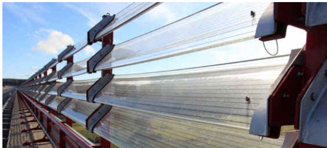
D-Ilmenau, A71, Reichenbachtalbrücke, KOHLHAUER SCORSA® BORA
