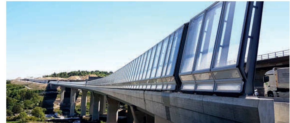
D-Talbrücke Heidingsfeld, A3, Norymberga-Frankfurt, KOHLHAUER SCORSA® FLEX
