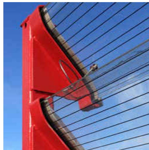
D-Ilmenau, A71, Reichenbachtalbrücke, KOHLHAUER SCORSA® BORA
